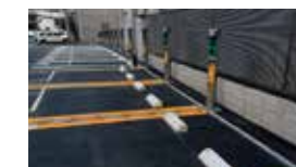
駐車場ロックレスシステム採用
