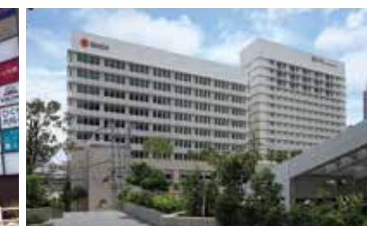
カフーナ旭橋C街区(那覇市)
